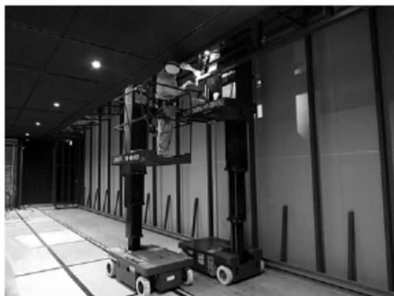
背面柱取り付け
