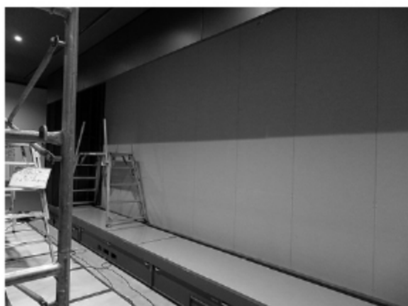
内装造作工事中
